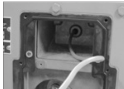
Figure 9.16 - Acheminez le câble à l'arrière du compteur.
