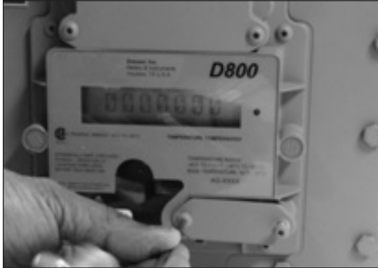
Figure 9.1 - Retirez deux vis à tête ronde
