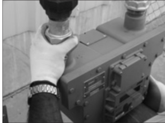
Figure 7.2 - Connectez l'embout du compteur dans l'écrou orientable du côté d'alimentation en gaz.
