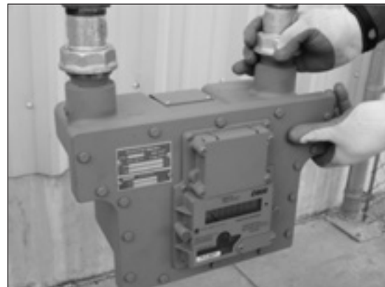
Figure 7.3 - Reliez la sortie du compteur à l'écrou orientable sur côté aval
